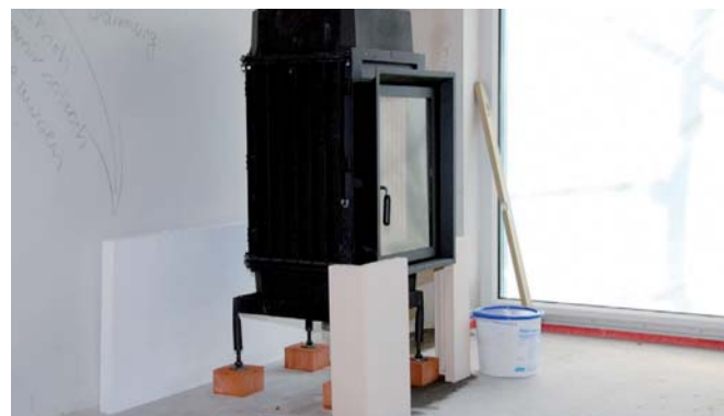
Установка топки для кафельной печи
