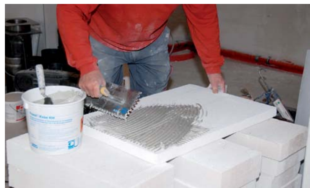
Нанесение клея Promat®-K84 на PROMASIL® 950-KS
